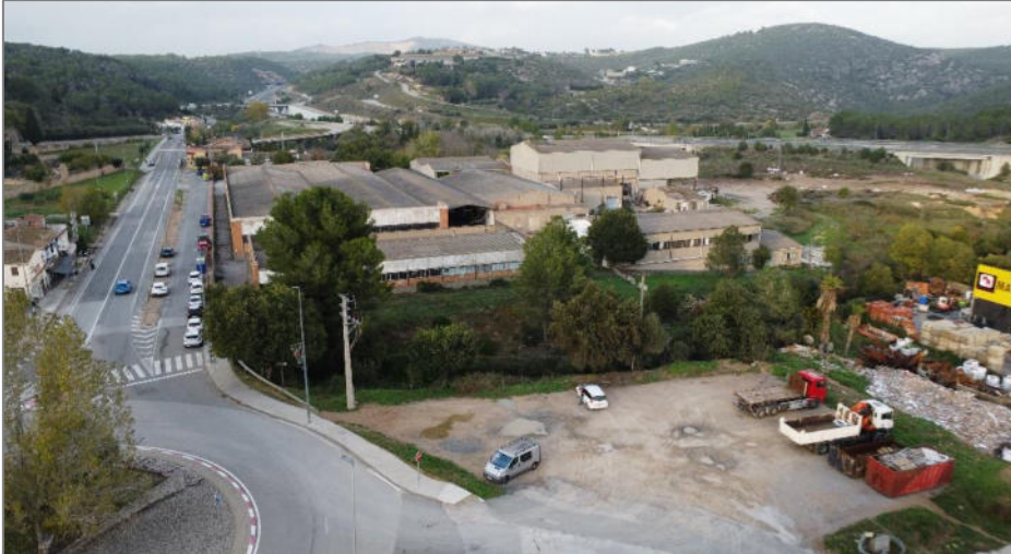
Fotografia 22. Vista S-N del PAU-2, amb el sòl nu, el torrent del Pla del Bosc i l'Av. de Vilafranca (C-15z) a esquerra. Al fons, s'observa la C-15 i els túnels que comuniquen l'Alt Penedès amb el Garraf.
