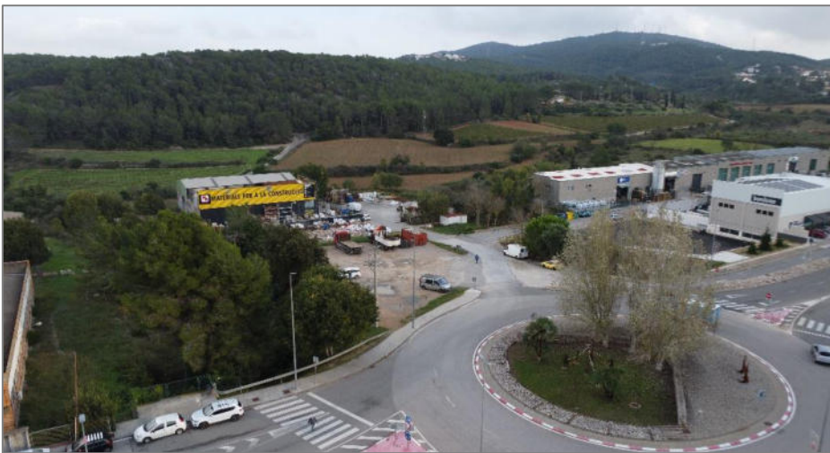
Fotografia 23. Vista NO-SE de la rotonda de la C-15z a l'extrem NO del PAU-2.
