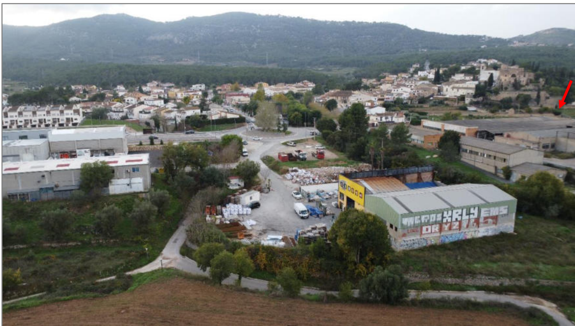
Fotografia 7. Vista SE-NO de l'àmbit PAU-2 amb l'activitat de materials de construcció (Excavacions Álvaro) i el camí de Canyelles a primer pla, i al fons, l'avinguda de Vilafranca. Al fons, el nucli de Canyelles i el castell. Al costat dret de la imatge (assenyalat amb una fletxa), el PAU-1.
