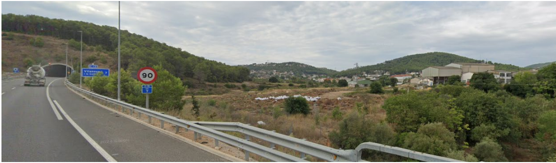
Fotografia 3. Carretera c-15 amb el límit del PAU-1 (Límit nord-est)
