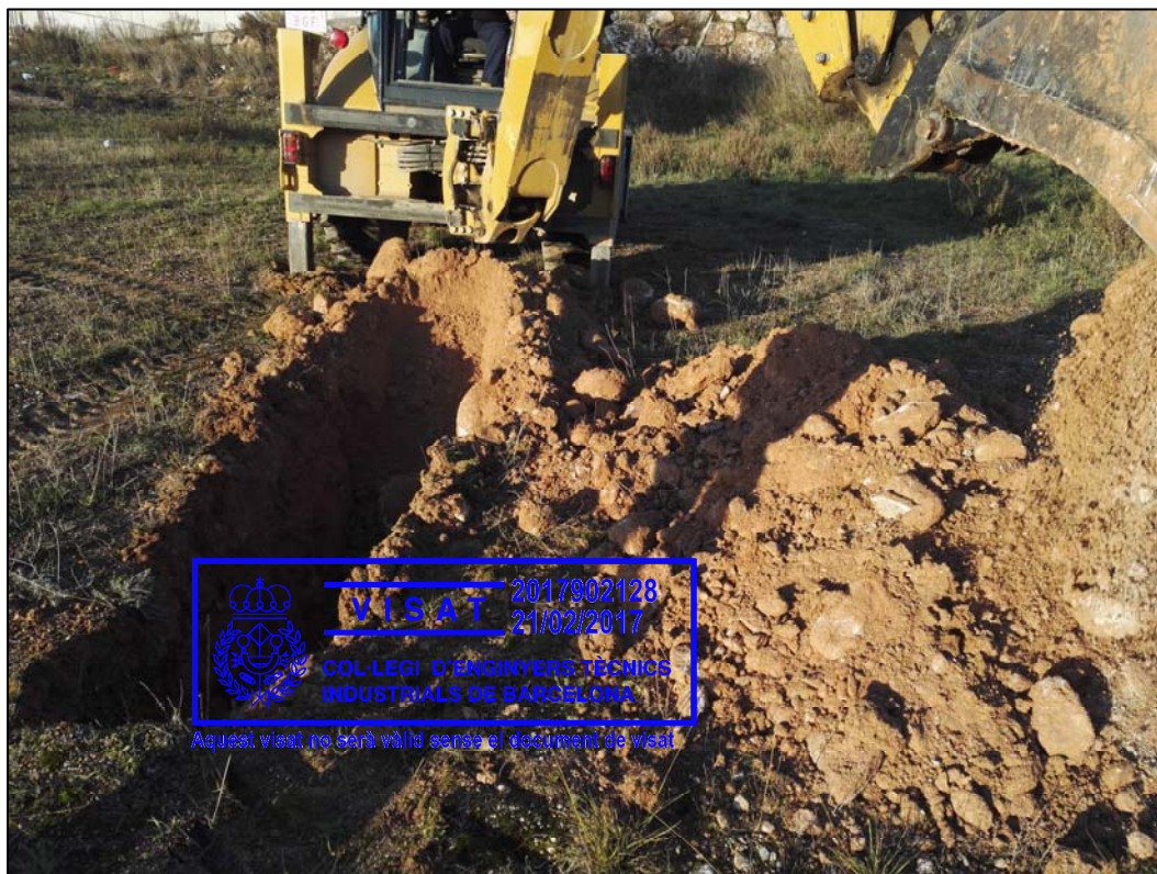
Foto 5. Execussió de cala C1 dins unitat B a zona SW de l'emplaçament.
