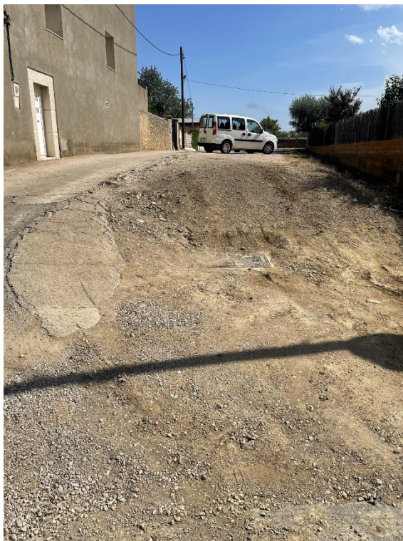
Figura 5. Rampa accés al carrer i xarxa de telecomunicacions
