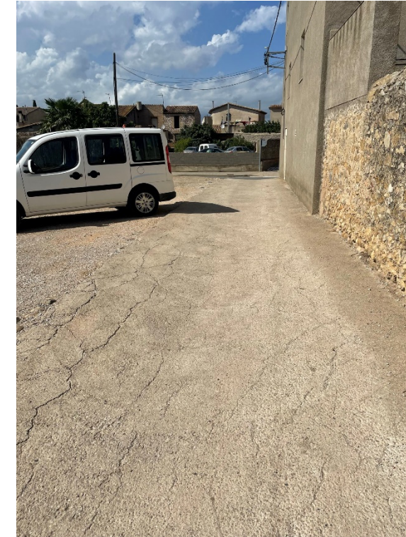
Figura 6. Paviment existent costat Est
