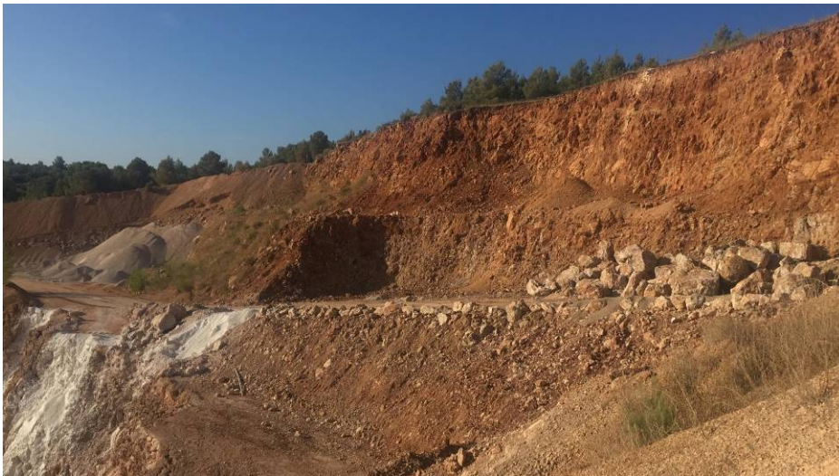
Foto 12. Visual de l'extractiva cap al Sud-Oest on s'aprecia els talussos perimetrals d'explotació-restauració de l'activitat minera que fan el fossat on s'emplaçarà la planta de tractament i quedarà tancat de visuals.
