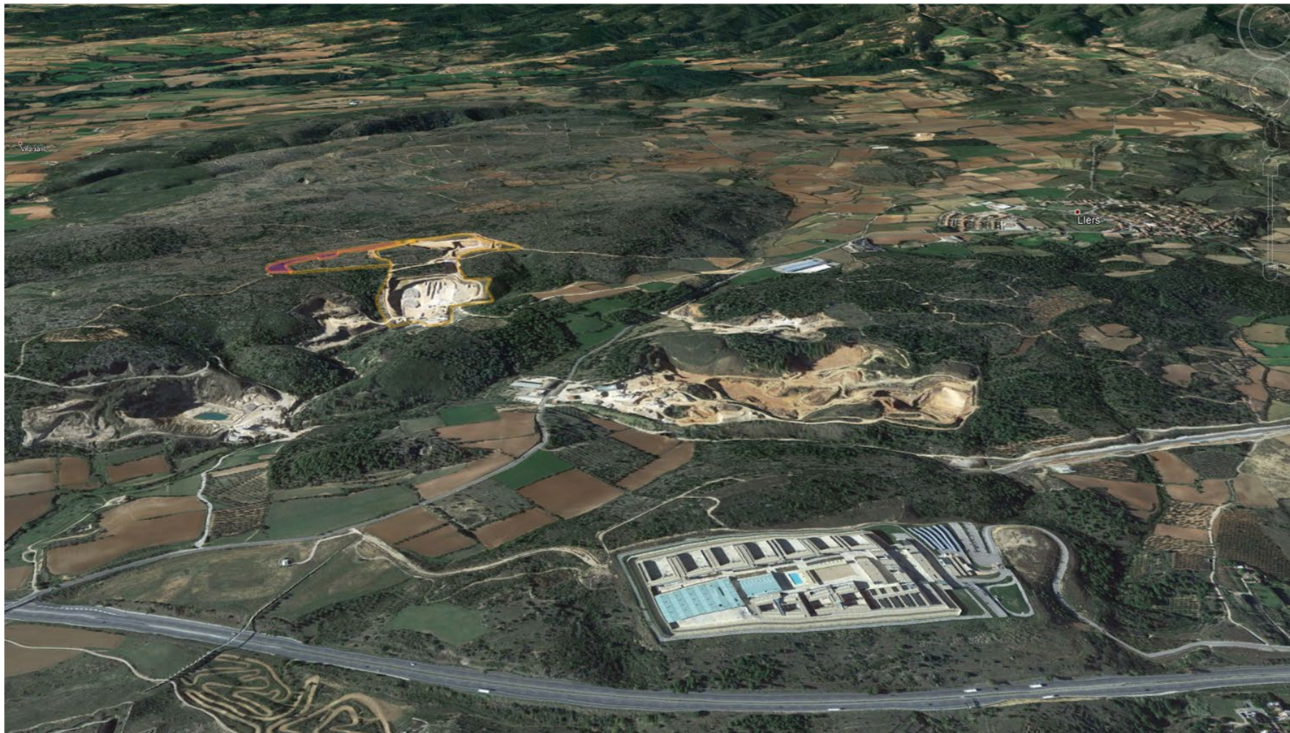
CONCA VISUAL DE L'ÀMBIT MINER ESPERANÇA (TRAMUNTANA I AMPLIACIÓ). EN COLOR MAGENTA ÀMBIT AMPLIACIÓ DE LA ZONA EXTRACTIVA D6 VISTA D'EST A OEST
