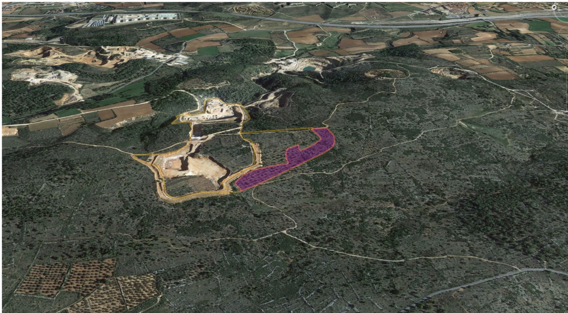
CONCA VISUAL DE L'ÀMBIT MINER ESPERANÇA (TRAMUNTANA I AMPLIACIÓ). EN COLOR MAGENTA ÀMBIT AMPLIACIÓ DE LA ZONA EXTRACTIVA D6. VISTA D'EST A OEST
