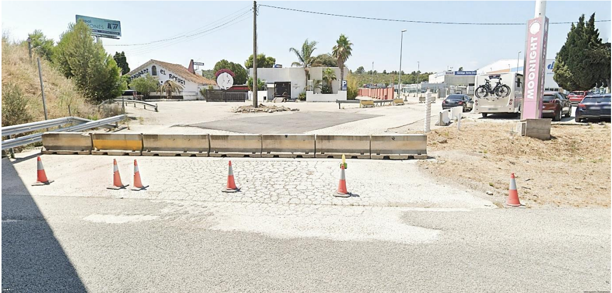
ACCES TANCAT AL CARRER HISPANO SUIZA DES DE LA CARRETERA N-II
