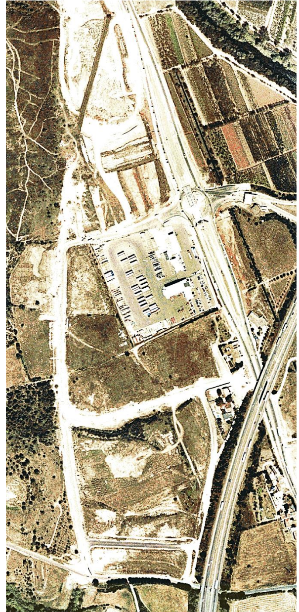
2004. OBRES D'ENLLAÇ A LA CARRETERA N-II
