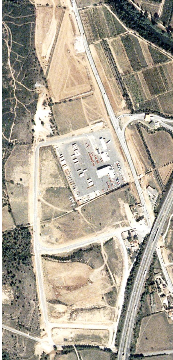
2003. OBRES D'URBANITZACIÓ DEL POLÍGON INDUSTRIAL
