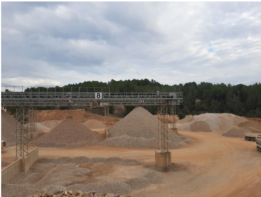
Foto 6. Es pot veure la planta de tractament (establiment de benefici). La imatge de fons és una pantalla formada pel conjunt d'arbres, que impedeix als possibles observadors veure la visió des de fora de la zona minera. Visió Est.
