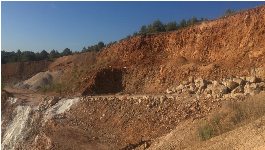
Foto 12. Visual de l'extractiva cap al Sud-Oest on s'aprecia els talussos perimetrals d'explotació-restauració de l'activitat minera que fan el fossat on s'emplaçarà la planta de tractament i quedarà tancat de visuals.
