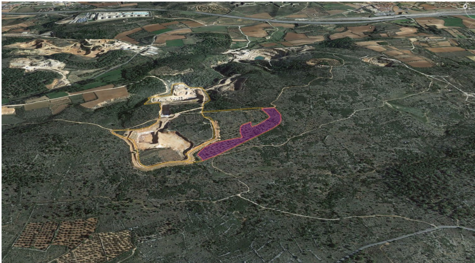
CONCA VISUAL DE L'ÀMBIT MINER ESPERANÇA (TRAMUNTANA I AMPLIACIÓ). EN COLOR MAGENTA ÀMBIT AMPLIACIÓ DE LA ZONA EXTRACTIVA D6. VISTA D'EST A OEST
