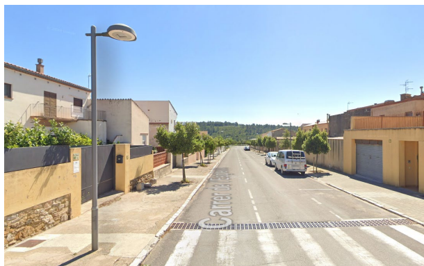
Figura 15. Columnes enllumenat, arbrat i reixes de drenatge existents al C/ de l'Eslésia
