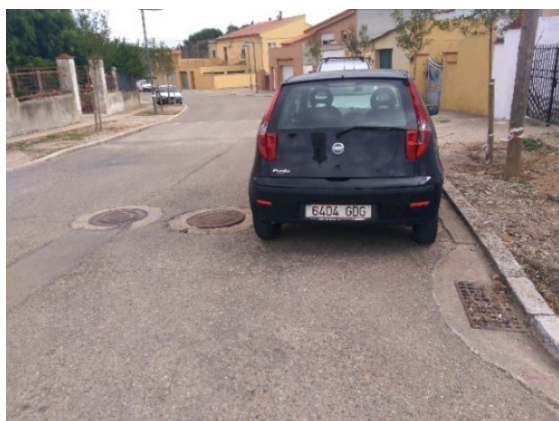
Figura 5. Estat actual Carrer Església. Manca d'ordenació d'espais i mal estat del paviment. Voreres en trams sense pavimentar.
