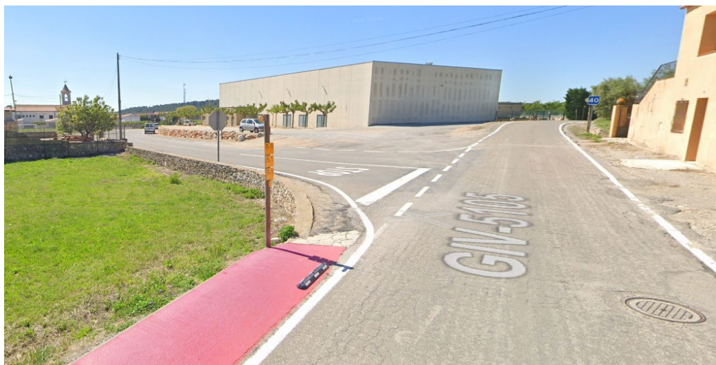
Figura 12. Vista de l'accés al carrer de l'Església des de la carretera GIV-5105, al nucli urbà de Llers
