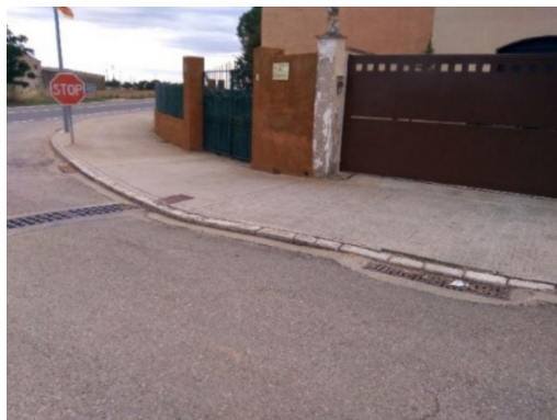
Figura 14. Elements xarxa de drenatge a adequar al C/ de l'Eslésia: embornals i reixes transversals
