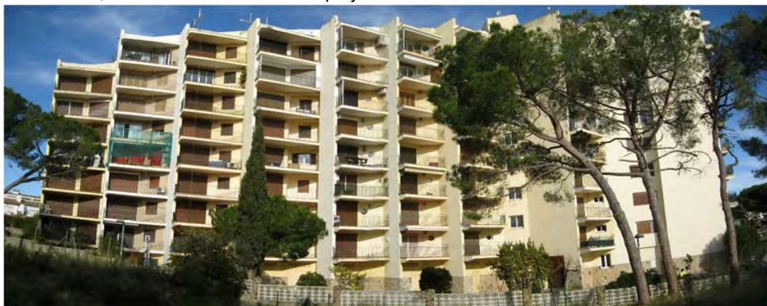
Edifici Proa, al nord-est de la zona del projecte.
