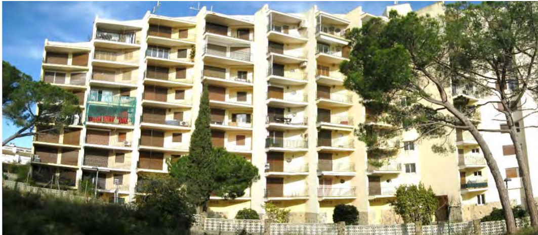
Visual de l'edifici Proa des del carrer del Rec
