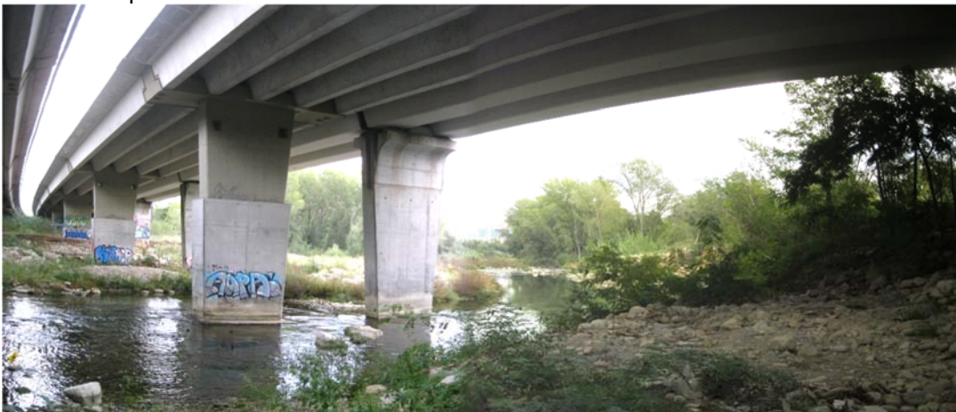
Viaducte de l'autopista AP-7 per creuar el riu Ter a l'entorn de les Deveses.
