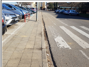
Tram 25: Carrer de Sant Dionís
