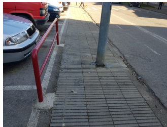
Barana de protecció
