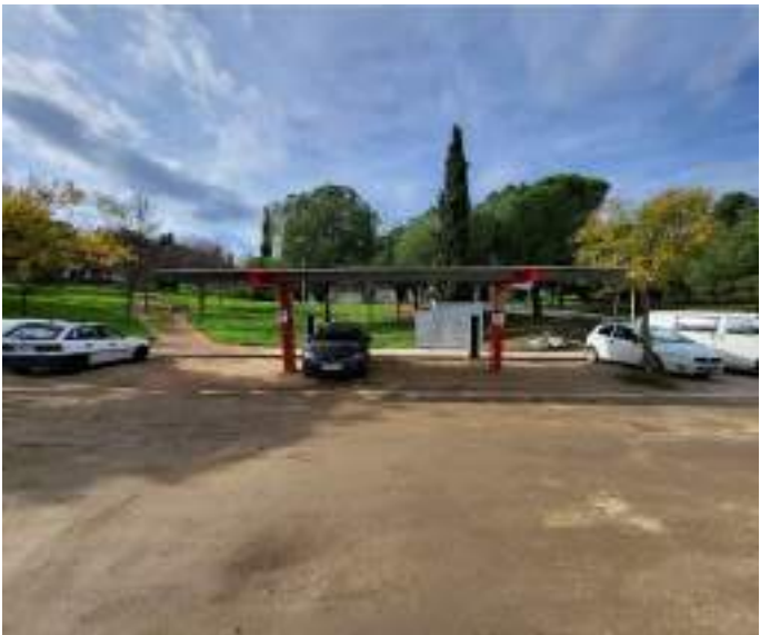
IMATGE 05 Vista frontal de la marquesina metàlica
