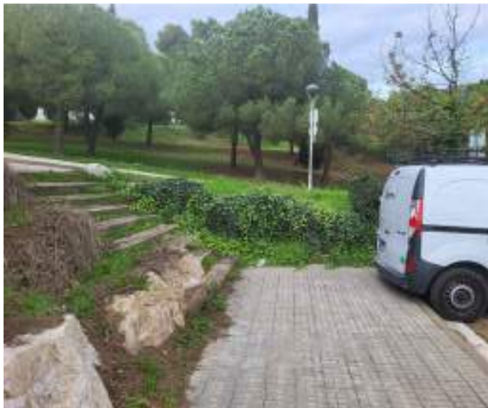
IMATGE 15 Contenció de terres a base de roques
