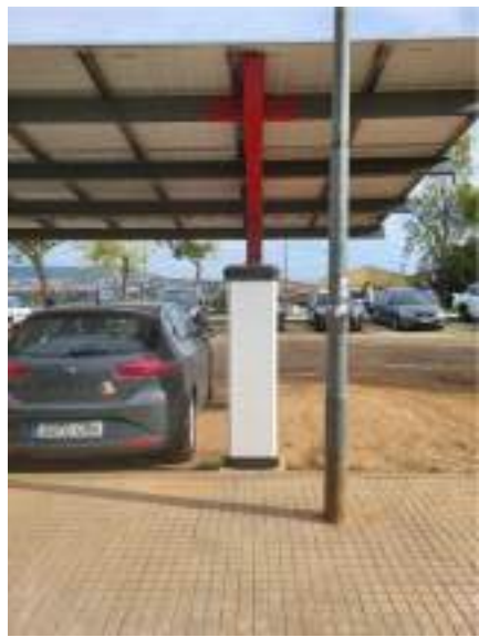
IMATGE 13 Detall de marquesina metàlica
