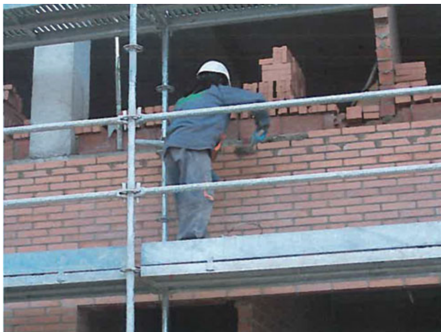
EXECUCIÓ DE PARETS DE TANCAMENT DES DE BASTIDA TUBULAR
