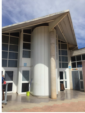
Figura 3. Façana del pavelló
