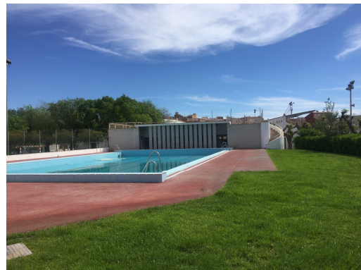
Figura 2. Façana de l'edifici
