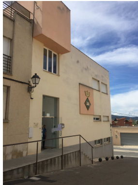
Figura 9. Façana exterior edifici
