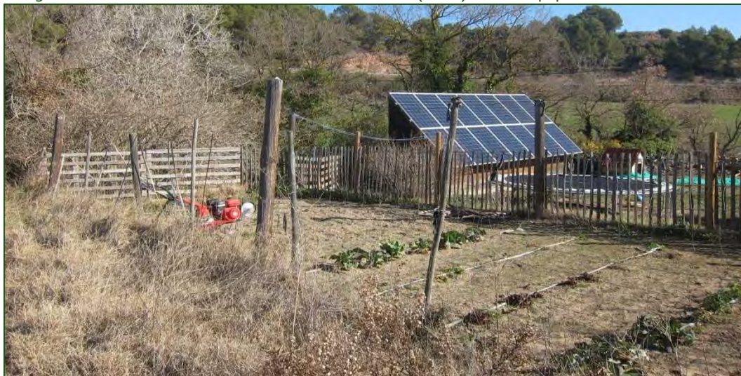
Fotografies 11: Instal·lacions solars a la Casa del Pont (M.25). Font: Equip redactor 2023.
