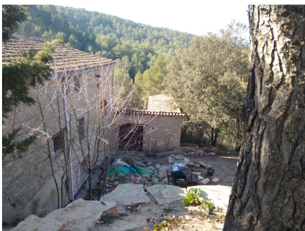
7. Façana nord-oest i annex
