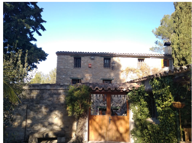
2. Façana est i portal d'entrada
