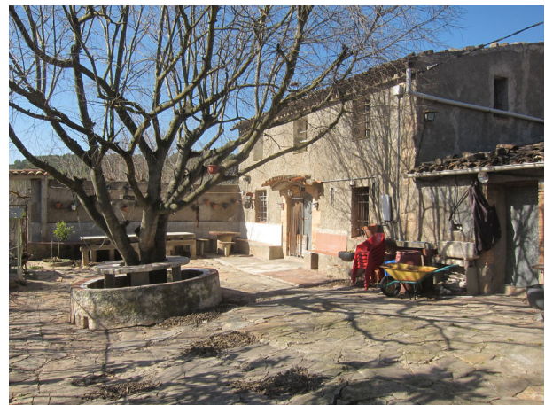
2. Façana principal sud-est
