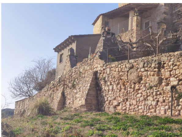
5. Detall closa sud
