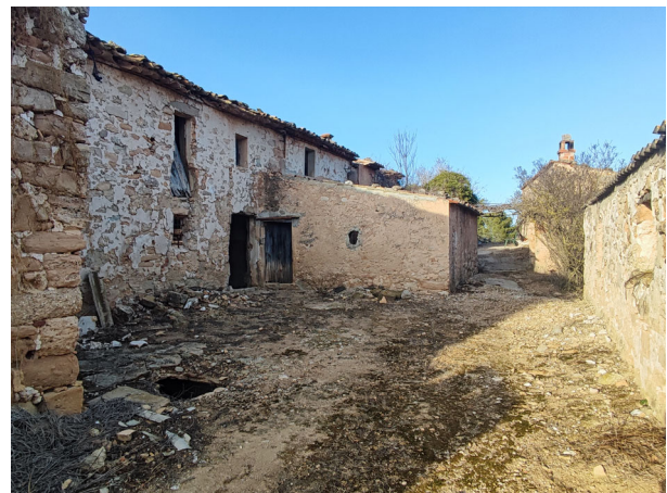
2. Vista interior del conjunt
