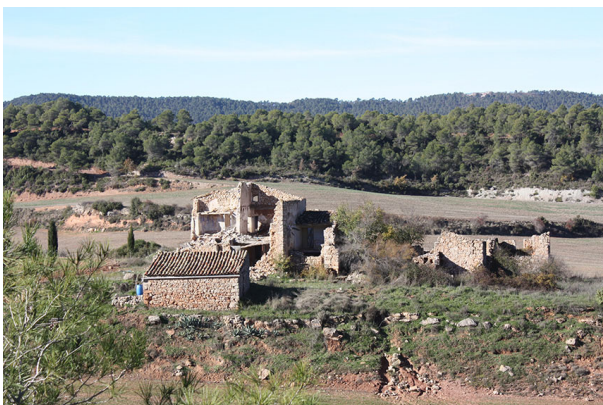
1. Vista general de la ruïna
