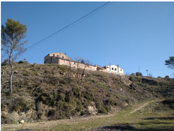
1. Vista del conjunt des del sud-oest
