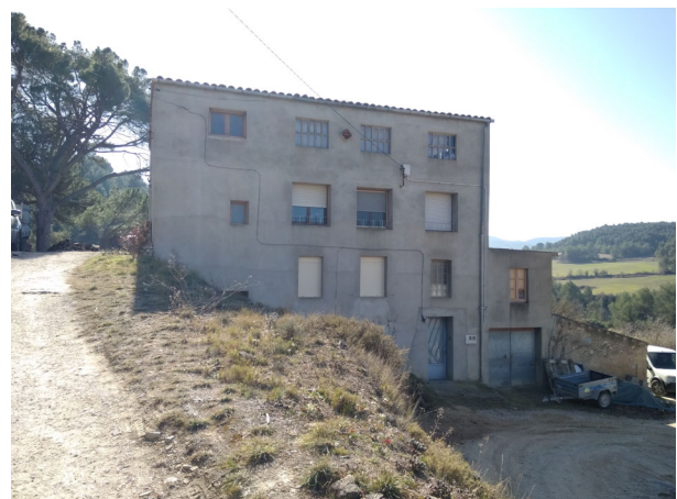
2. Façana nord i accés
