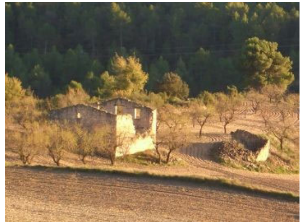
2. Vista del conjunt i entorn
