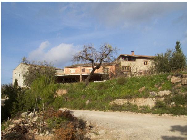
1. Vista del conjunt
