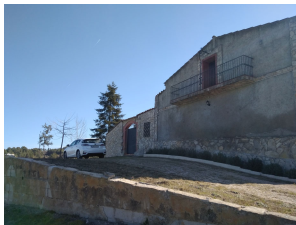
8. Volum principal façana nord
