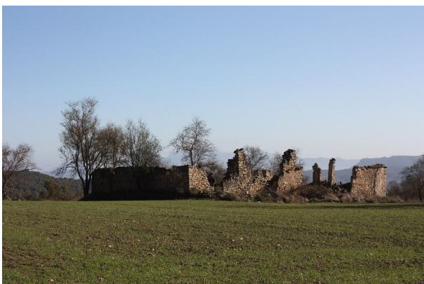
1. Vista del conjunt en ruïnes
