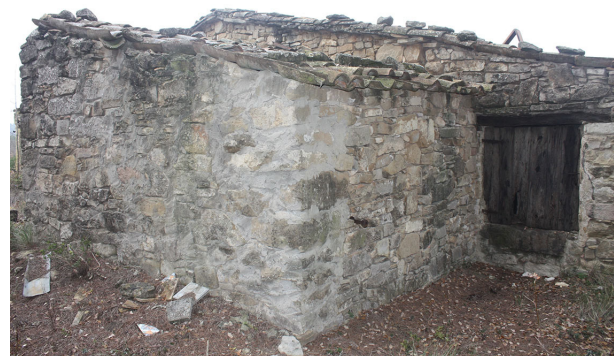
2. Detall estat dels murs
