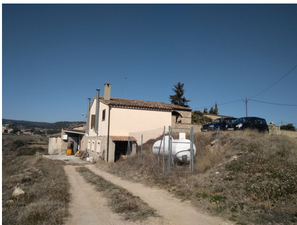
7. Vista del conjunt des del sud-est
