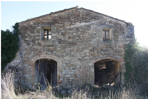
3. Façana principal oest
