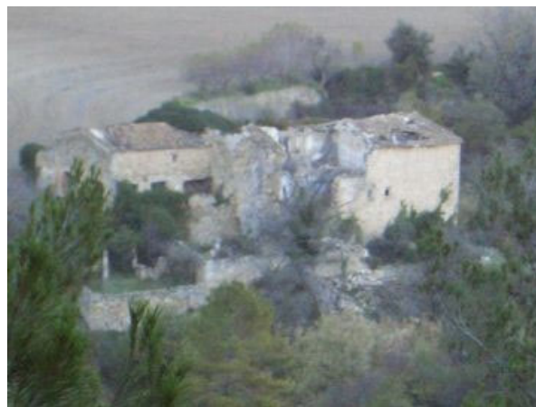
4. Vista del conjunt
