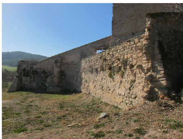
6. Vista est de la closa
