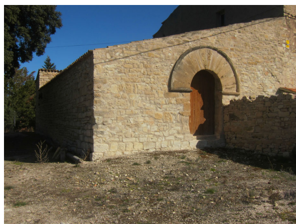
6. Arc de mig punt a l'annex sud-oest
