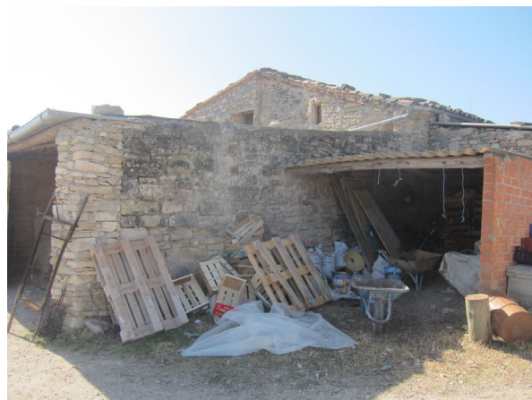
6. Vista annexos nord-est
