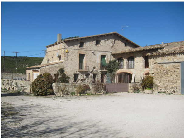
1. Vista del conjunt
