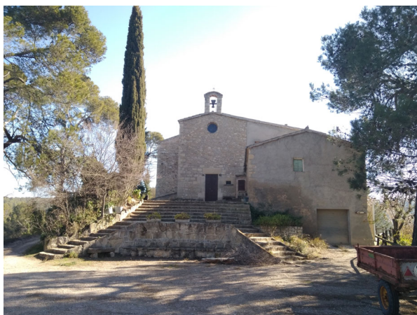
3. Façana principal oest
