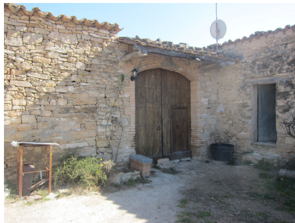
8. Portal d'entrada oest
