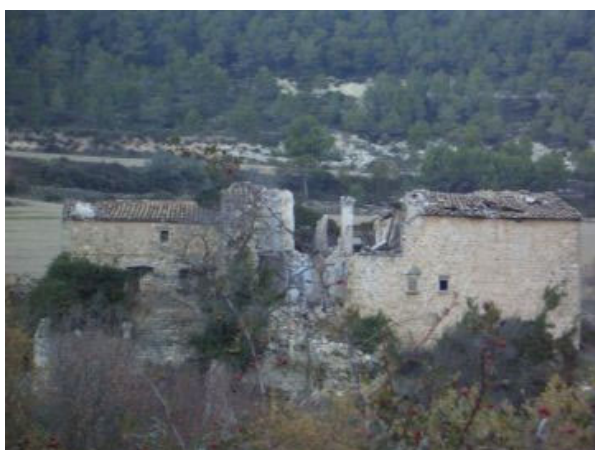
5. Vista del conjunt
