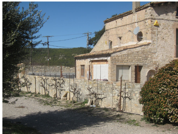
4. Façana sud-oest i closa
