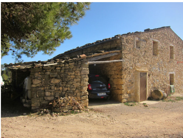
1. Façana principal oest
