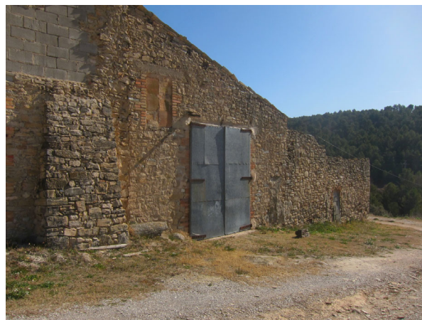
4. Façana annex oest
