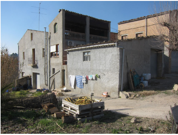
3. Conjunt façana sud
