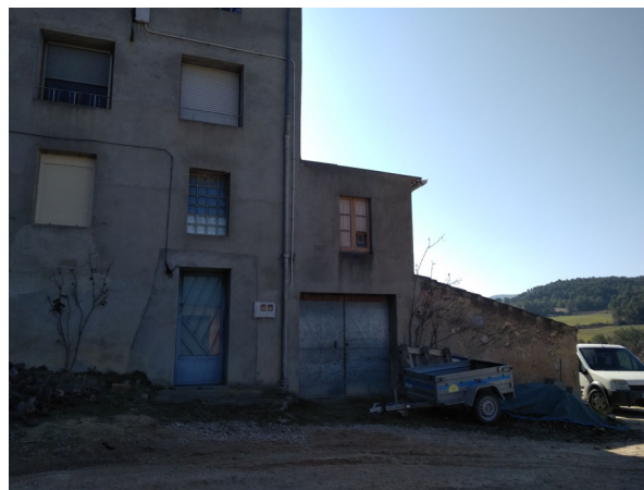
4. Façana nord i annex
