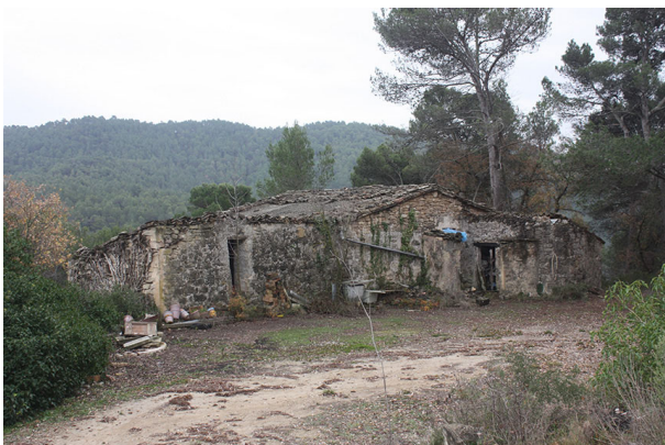
1. Vista del conjunt
