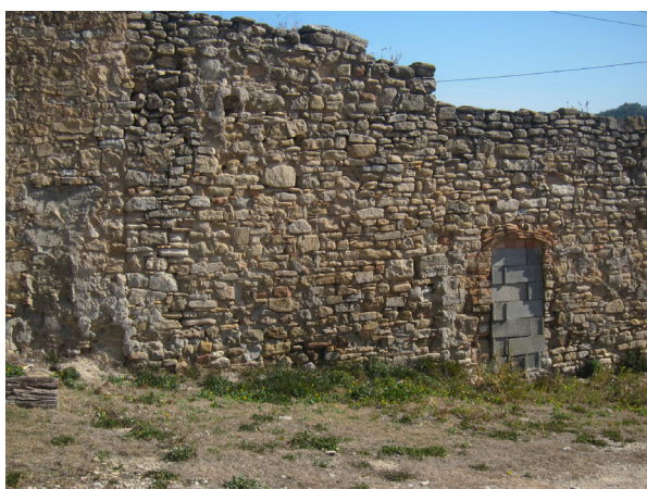
5. Façana annex oest
