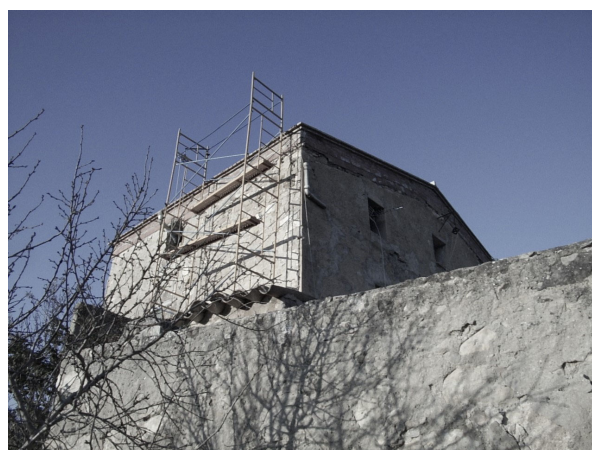
6. Façana sud-oest antiga
