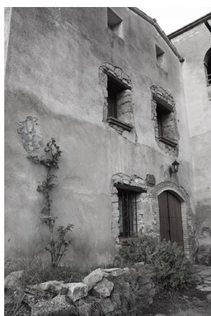
5. Façana principal sud antiga
