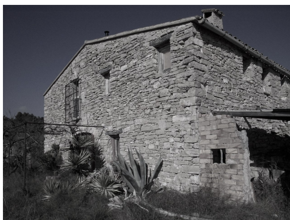
6. Façana principal sud-oest
