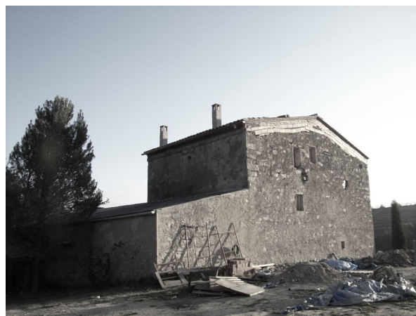
8. Façana nord-oest antiga
