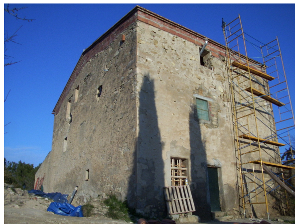
4. Façanes sud i oest
