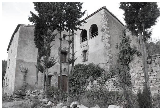
6. Façana principal sud antiga
