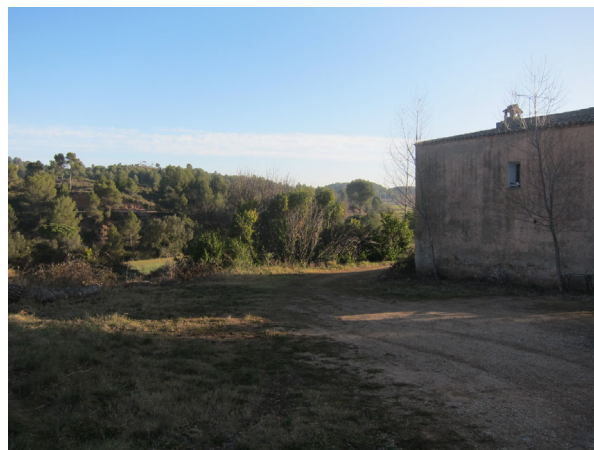
4. Façana Oest i Entorn
