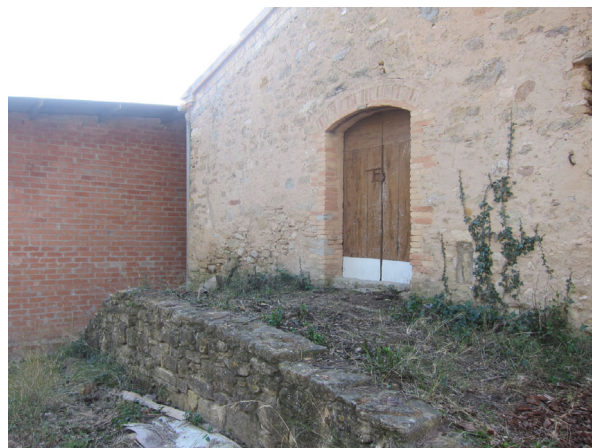
4. Portal annex nord
