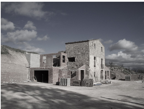
5. Foto antiga en construcció
