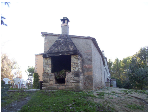
1. Forn annex oest
