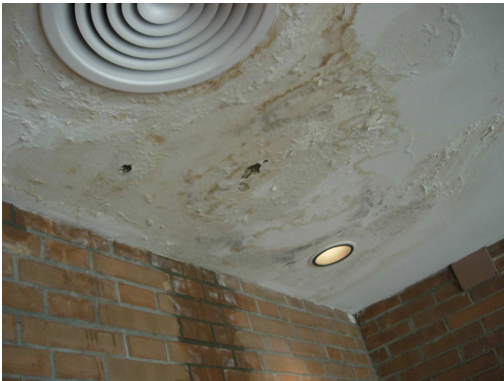
FOTO 3. Vista d'una de les nombroses filtracions en el vestíbul
