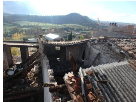
FOTO 4. VISTA DE PLAQUES DE FIBROCIMENT A PLANTA
