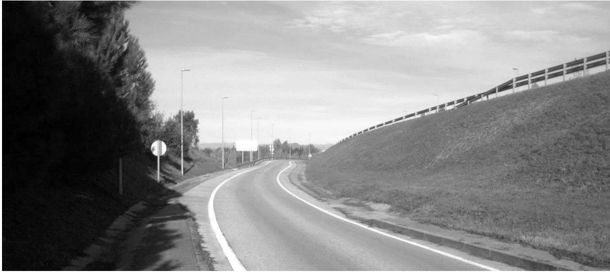
Figura 24. Ramal de sortida de la carretera C-65 a l'entorn de la zona 2
