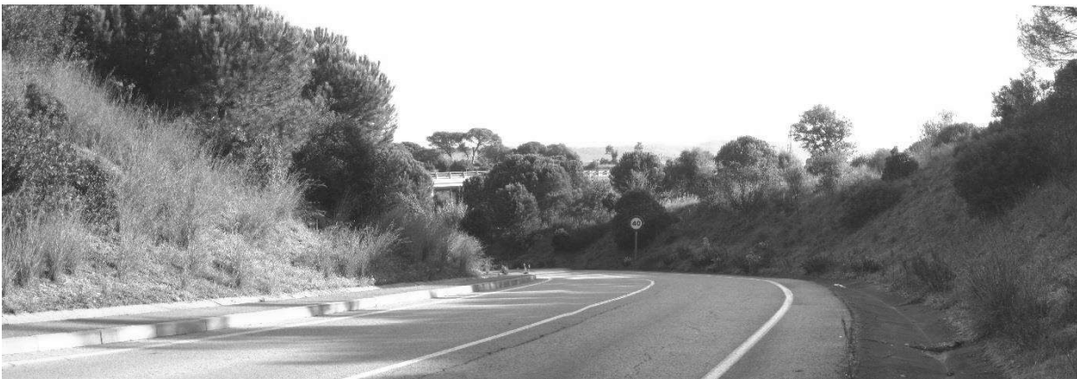
Figura 7. Talussos a l'entorn de l'enllaç de la carretera C-65
