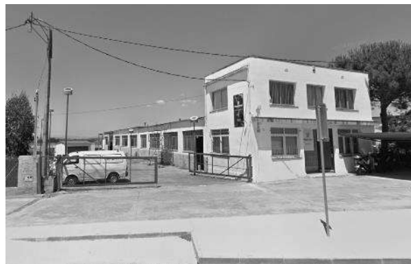
Figura 9. Imatge Edificació industrial – 22114-06
