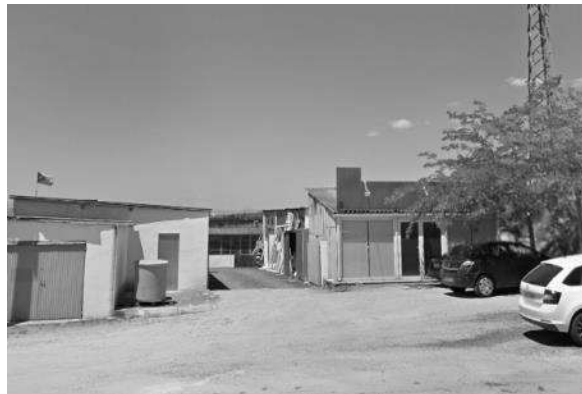
Figura 11. Imatge Edificació industrial – 22114-03
