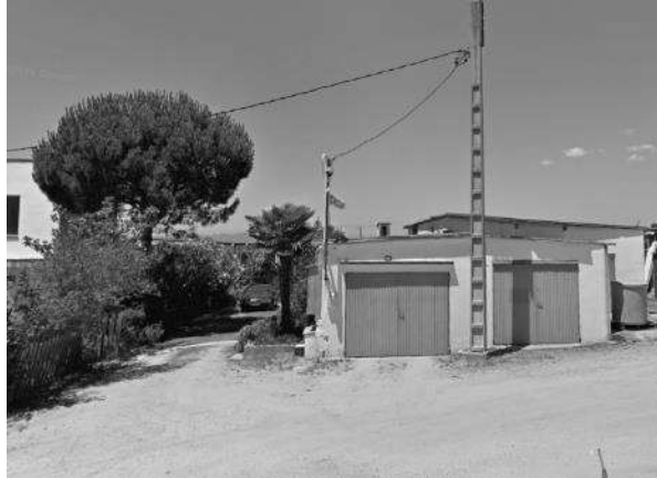
Figura 10. Imatge Edificació industrial – 22114-24
