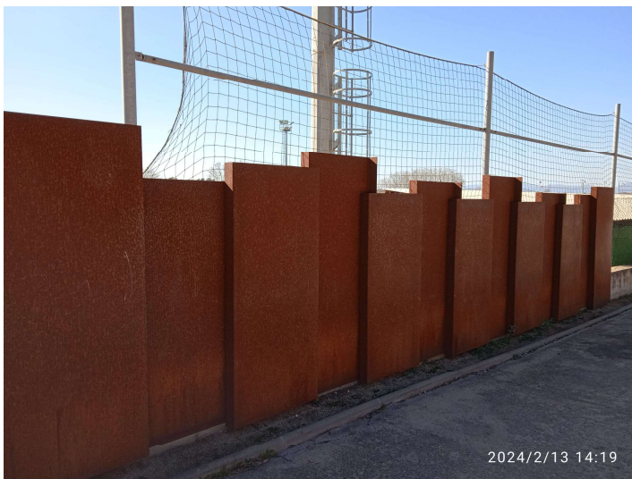
Tram de tanca de corten existent
