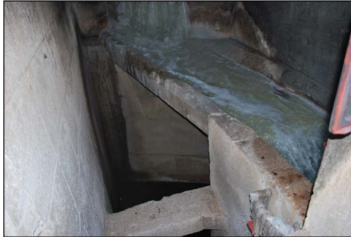
Figura 8. Imatge de sobreixidor en el creuament amb el torrent de la Bleda.
