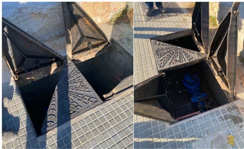
Imatge 9: Infografia exemple de detall de tapes d'arquetes finalitzades
