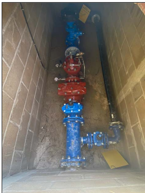
Imatge 6: Infografia exemple interior d'arqueta de sectorització (comptador i reguladora)
