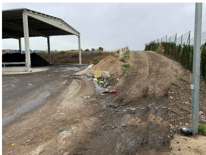
Imatge 9. Actual rampa d'accés a la planta de fracció vegetal, a reformar amb les actuacions d'aquest projecte.
