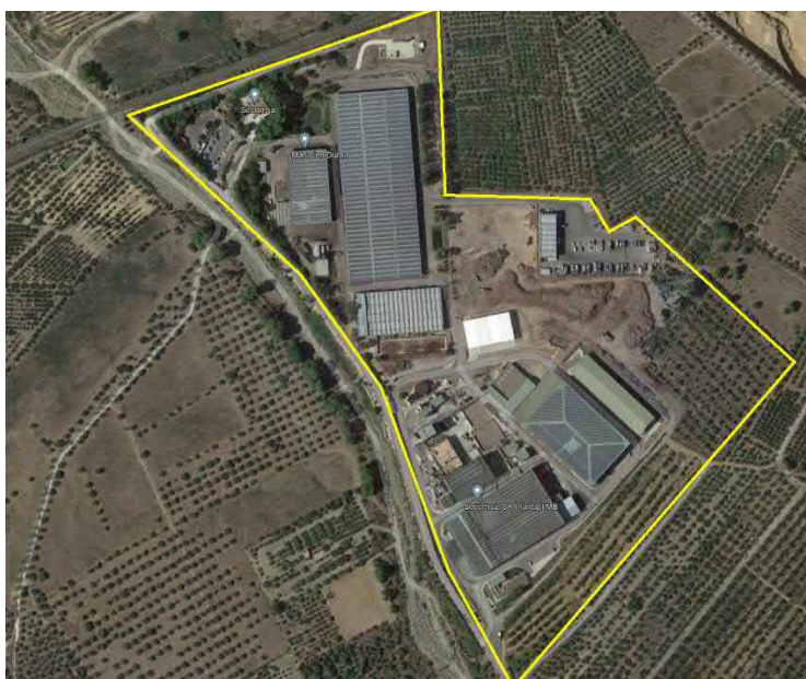
Imatge 1. Parcel·la actual de Secomsa amb el complex de tractament de residus. Botarell.
