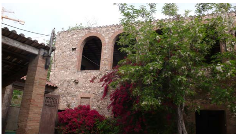
Fachada almacén de dos plantas
