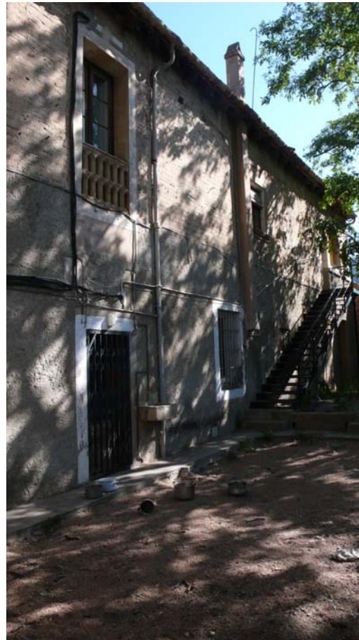
Fachada Este y zona no ajardinada
