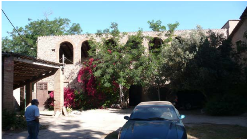
Patio de acceso entre edificación principal y el almacén
