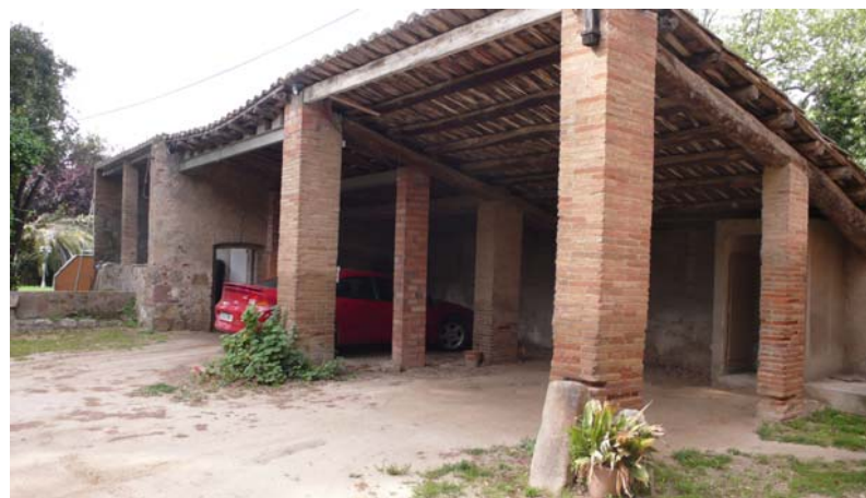
Cubierto en zona de acceso "era"
