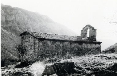
Vista lateral de l'església.
