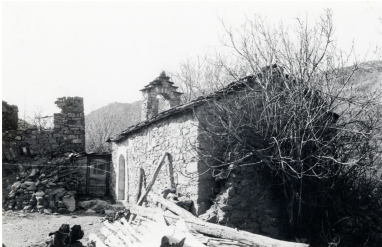
Vista exterior de l'església.
