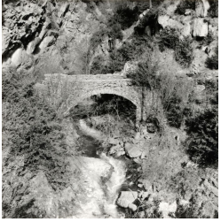
Vista general del pont.
