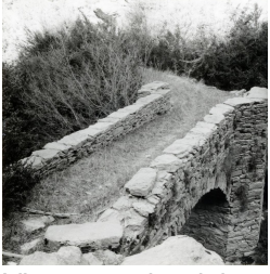
Vista superior del pont.
