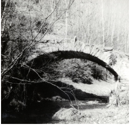
Vista de l'arcada del pont.
