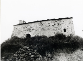
Vista lateral de l'església.
