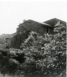
Vista exterior de l'església.
