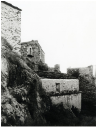
Vista lateral i edifici propers a l'església.
