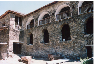
Vista de la façana posterior.
