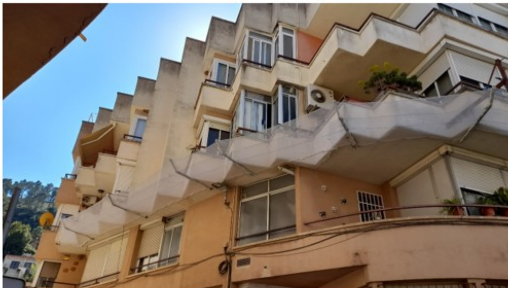
Imatge general façana a carrer Miquel Batlle
