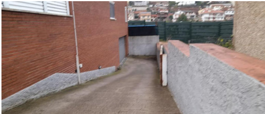
ACCÉS A LA PLANTA SOTERRANI I APARCAMENTS DELS NUMEROS 22-A a 22-K
