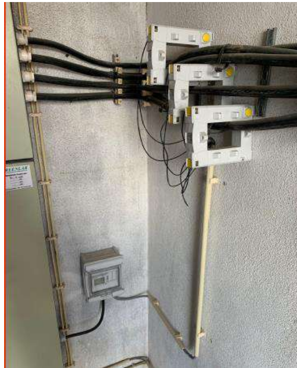
Fotografia 23. Instal·lació i fixació de cablejat.
