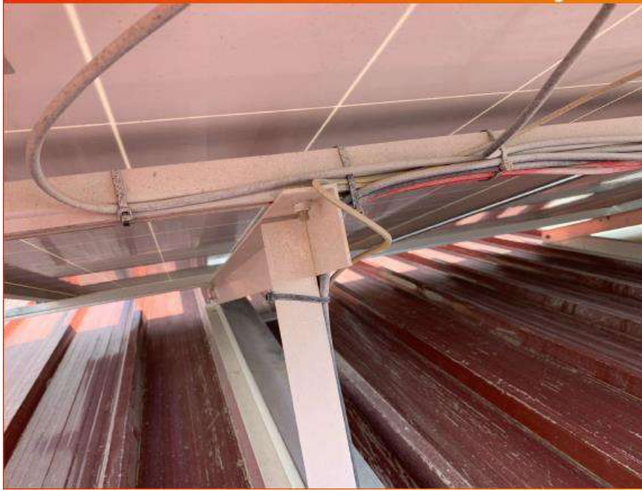
Fotografia 24. instal·lació i fixació de cablejat en estructura solar.
