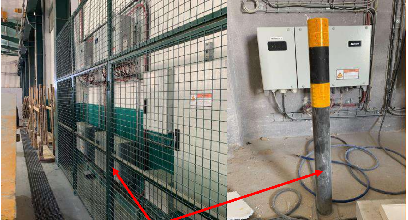
Fotografia 26. Protecció equips instal·lats.
