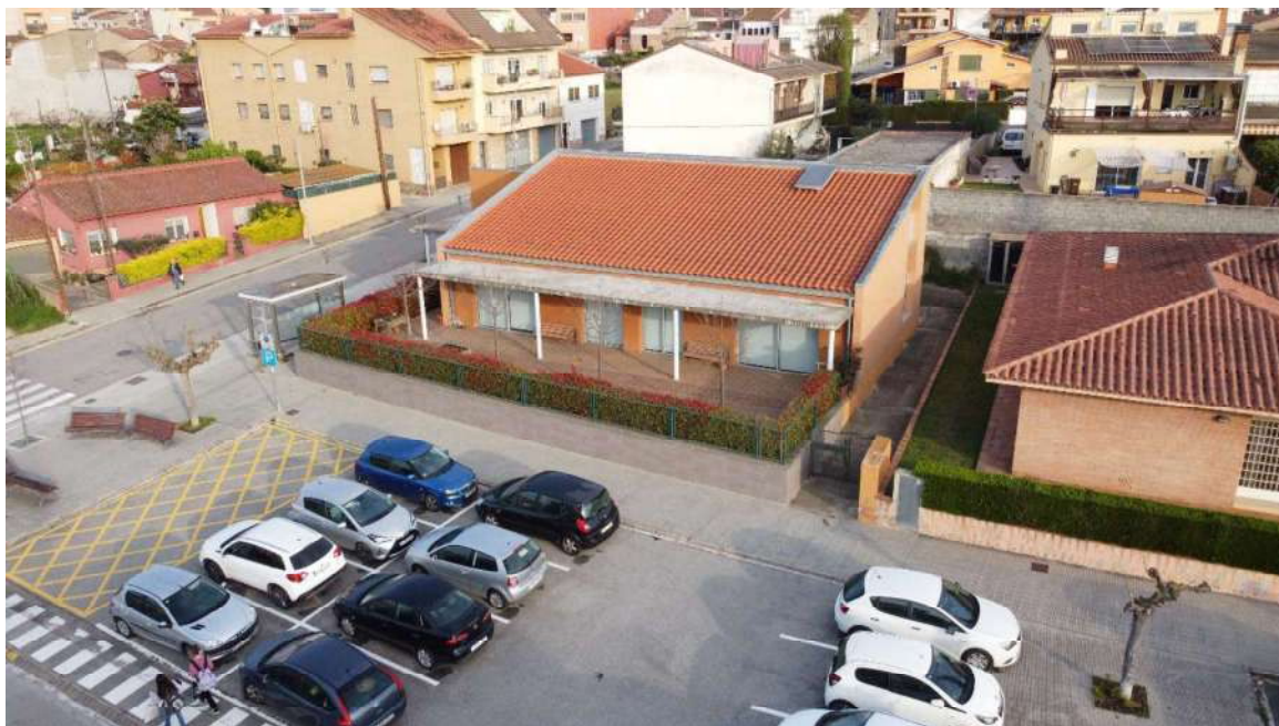
Il·lustració 5 - Imatge de l'edifici objecte del project
