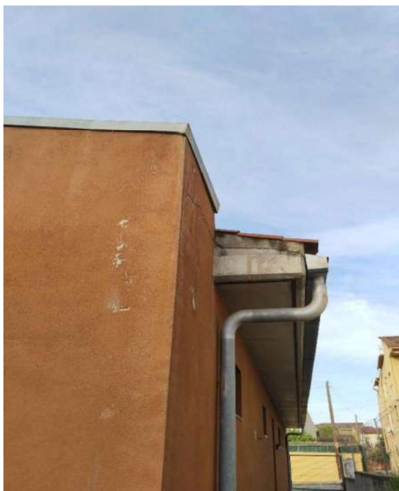
Il·lustració 4 - Detall coberta edifici
