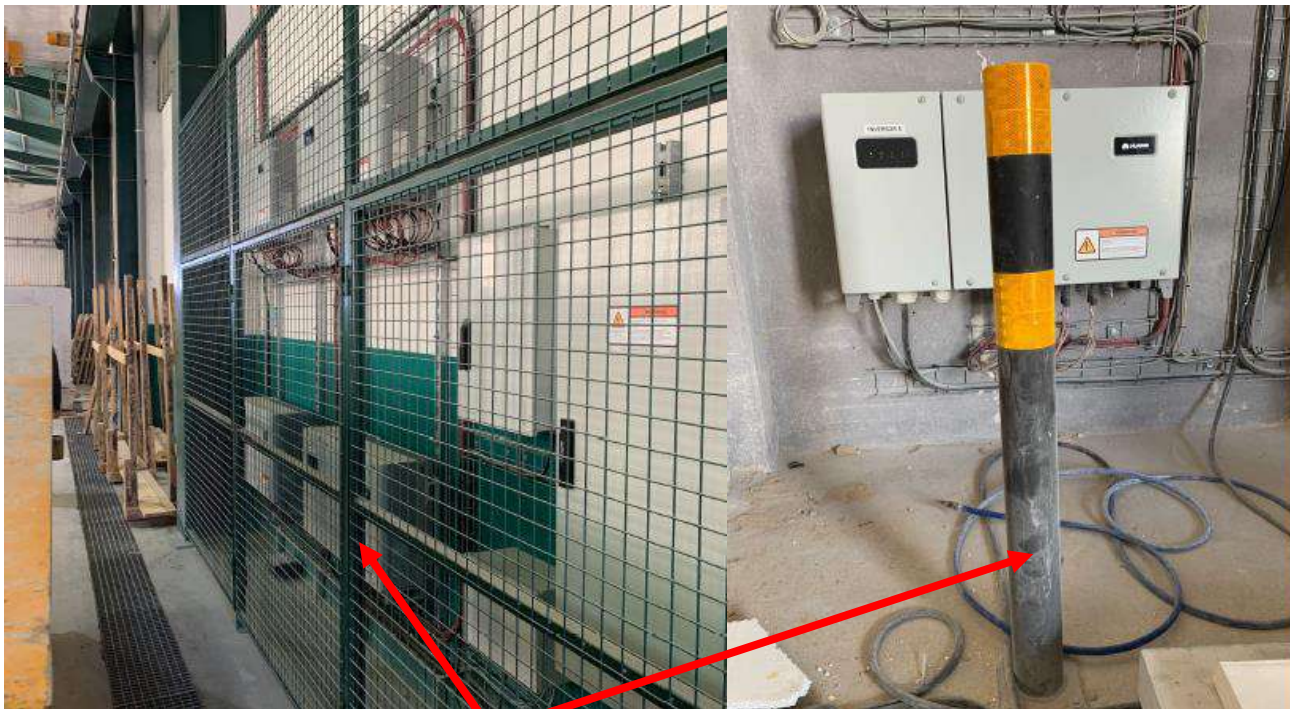
Fotografia 26. Protecció equips instal·lats.
