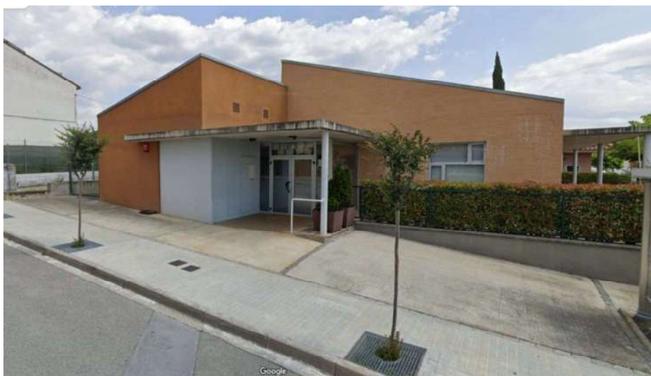
Il·lustració 1 - Edifici objecte del projecte
