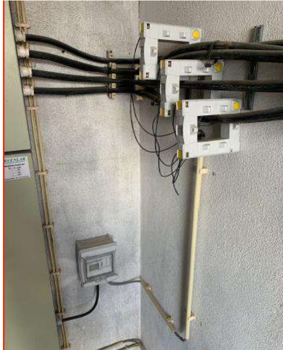
Fotografia 23. Instal·lació i fixació de cablejat.
