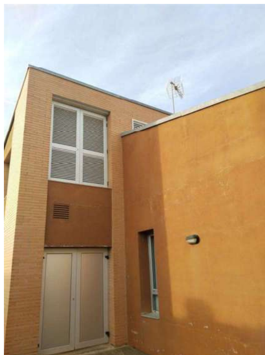
Il·lustració 6 - Detall estructura edifici
