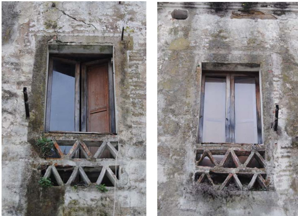
Imatges dels balcons del primer pis de la façana de l'habitatge número 6. S'observen els esgrafiats decoratius en el marc de les obertures
