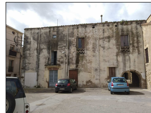
03 façana est des de la plaça del Convent
