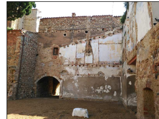
02 fachada oeste vista des del recinte del claustre (abans de col·locar-se les lones protectores)
