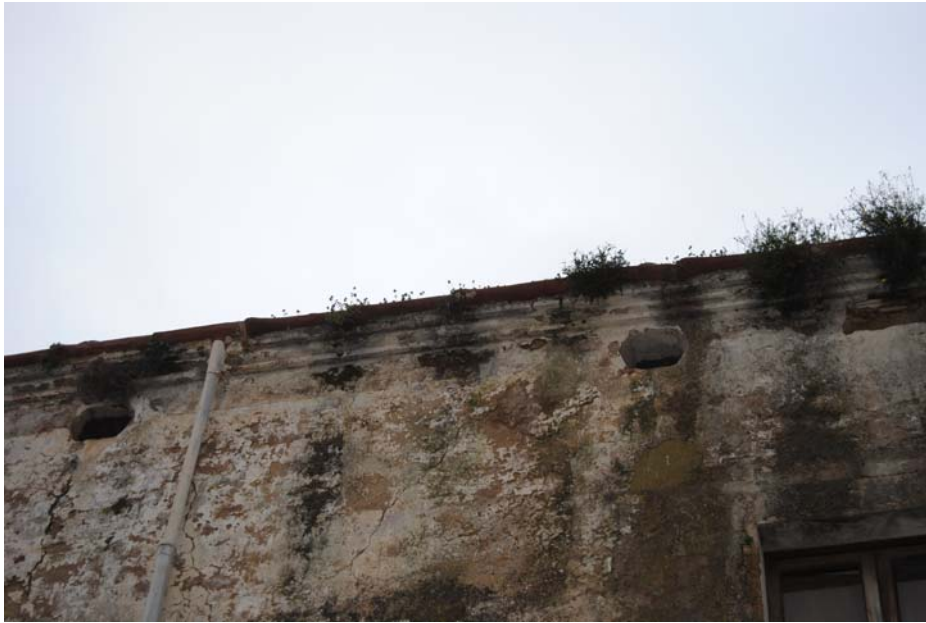
Obertures hexagonals a la part superior de la façana de l'habitatge número 6
