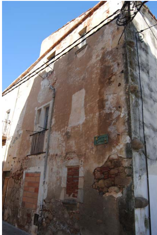
Vista general de la façana de l'habitatge número 15
