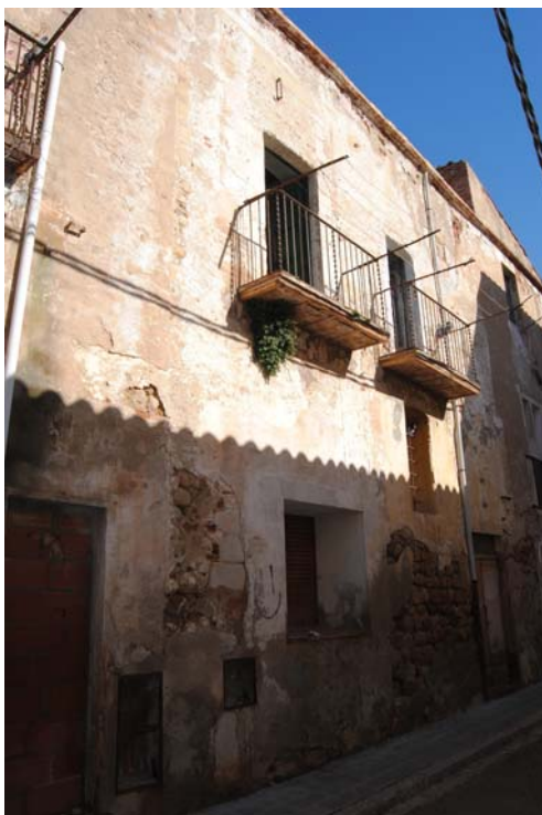
Vista general de la façana de l'habitatge número 13
