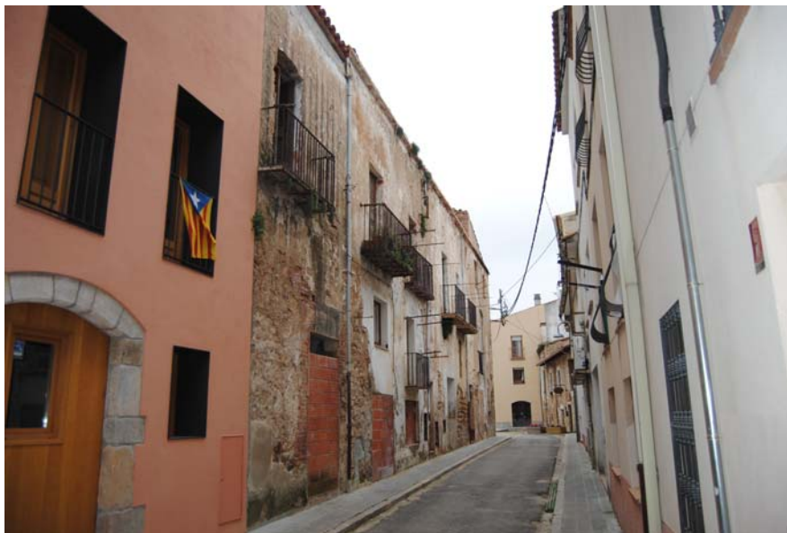
Vista general de la façana
