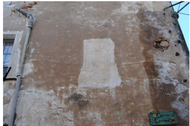
Imatge esquerra: antic balcó cegat. Imatge dreta: possible finestra tapiada
