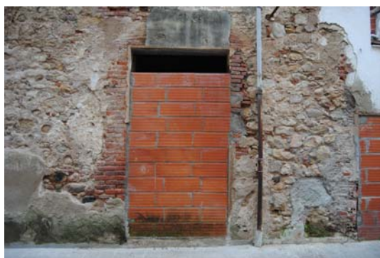
Portal de l'habitatge
