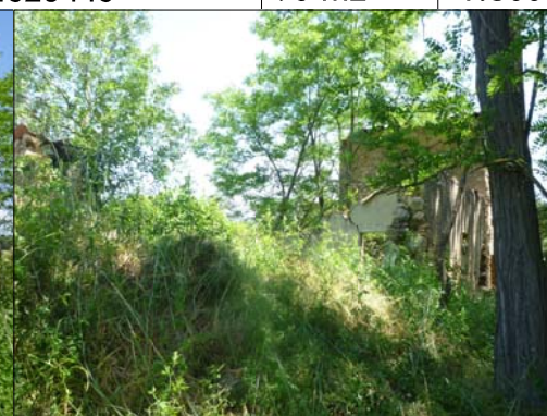
Façana sud (principal)
