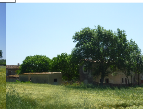
Edificació situada a l'oest del pati
