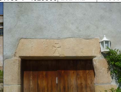
Detall entrada façana est
