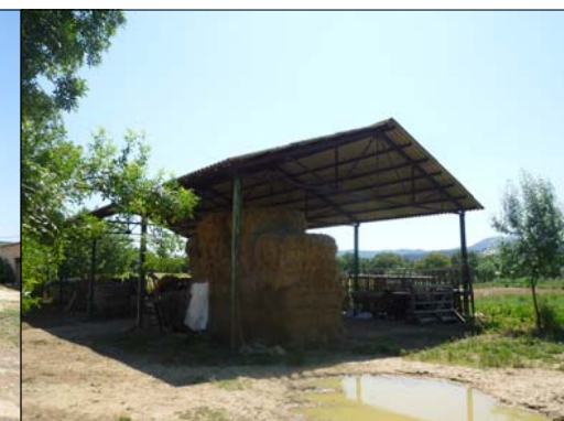
Cobert zona sud-est
