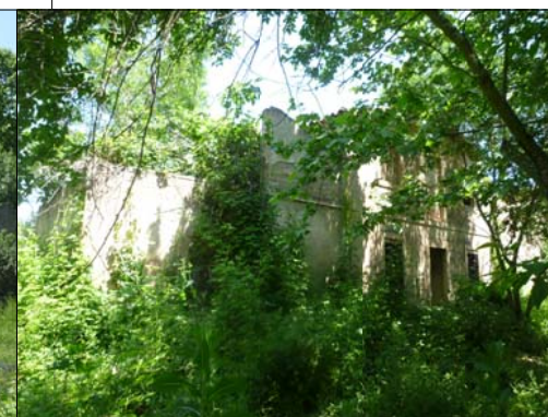
Detall façana sud
