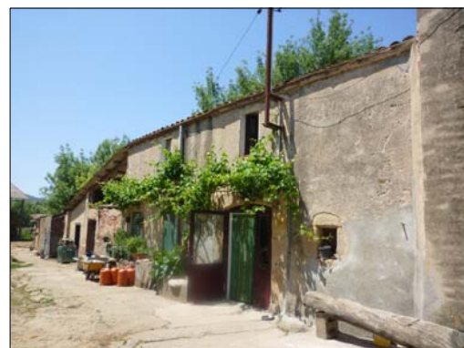
Façana est (principal)
