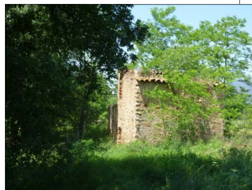
Façana sud (principal)
