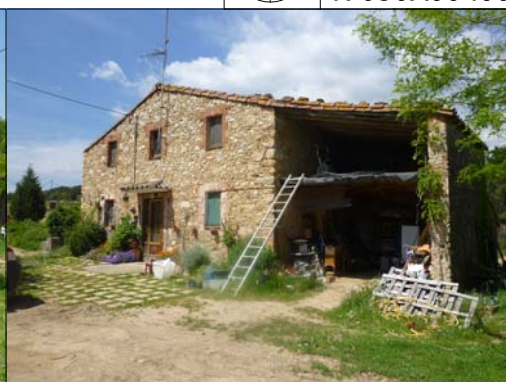
Façana est, amb el paller a la dreta
