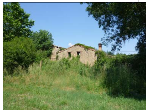
Façana sud (principal)
