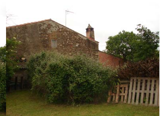
Façana nord, cobert annex
