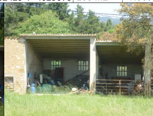
Façana sud coberts
