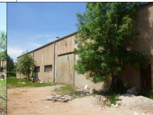
Façana est nau industrial
