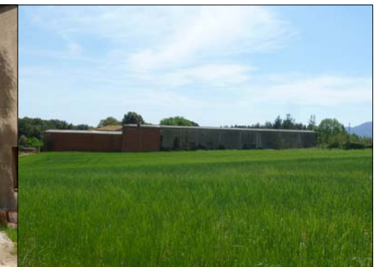
Façana oest nau industrial
