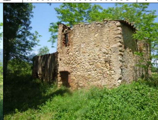
Façana sud (principal)
