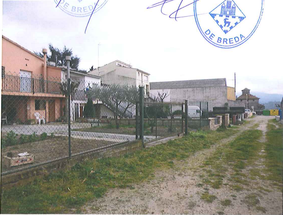
Illa 2: Vial interior que dona accés rodat a l'edificació principal amb front al C/ Rovira
