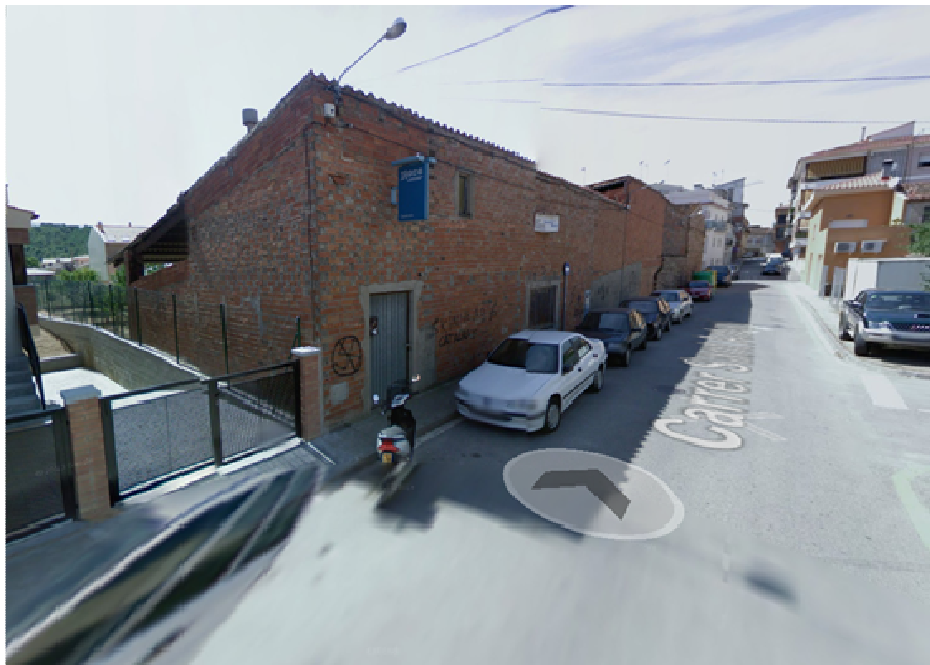
Vista des del carrer Sant Antoni de l'edificació secundària d'ús industrial i que caldria enderrocar.
