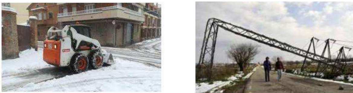
Figura 15. Afectacions a infraestructures i zones urbanes causades per la neu a Tarragona. Font: Riscos de tardor/hivern (Protecció Civil, 2023)
