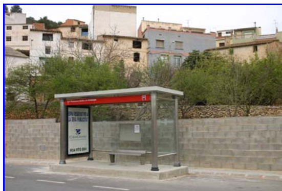
Foto nº73. Nova marquesina de la parada de l'autobús al Pont d'Armentera
