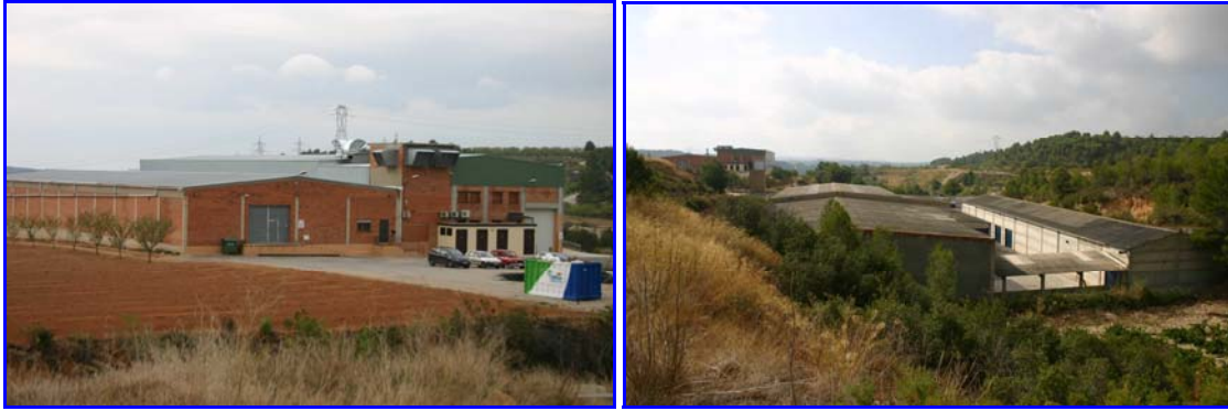
Foto nº81 i nº82. A l'esquerra, instal·lacions de GULTIG, i a la dreta, instal·lacions de TUBA.
