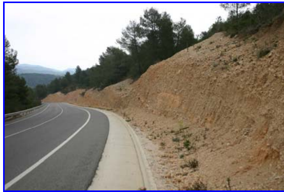
Foto nº25. Aspecte gens integrat dels desmunts de la carretera C-37 poc abans d'arribar al Pont
