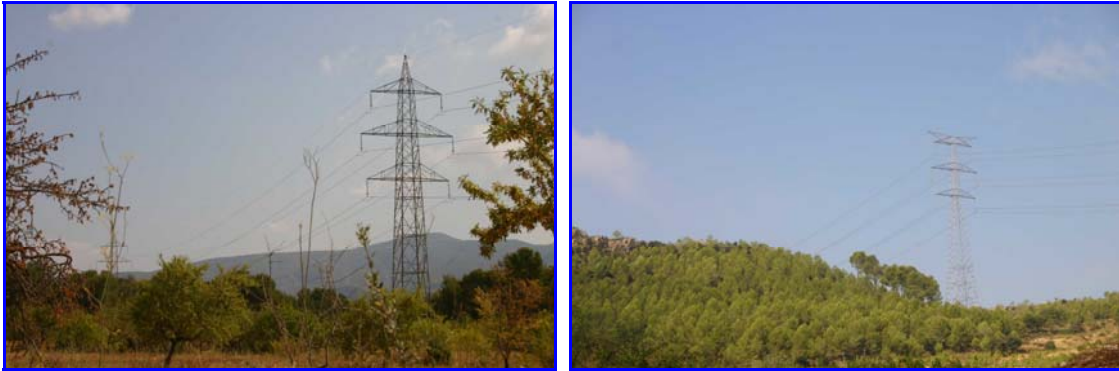
Fotos nº19 i 20. Respectivament, les línies d'alta tensió que recorren la zona de les Planes, al sud, i la serra de Comaverd, al nord
