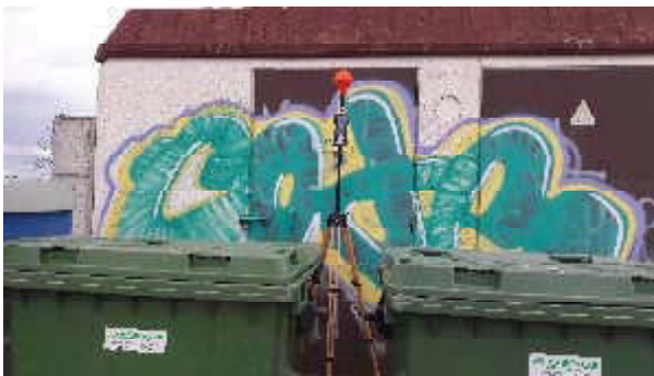
Punt de mesura 12: (LE) Transformador Fecsa 63777 Cr. 26, porta esquerra
