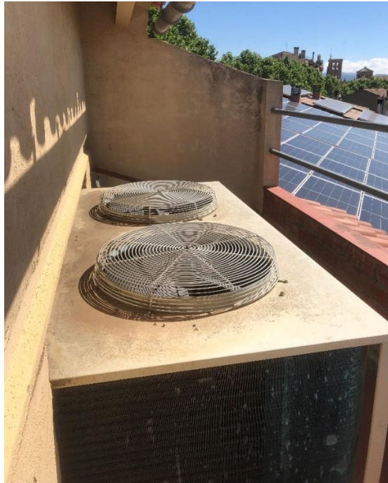
Figura 38: Envà a enderrocar i retirada de maquinària.
