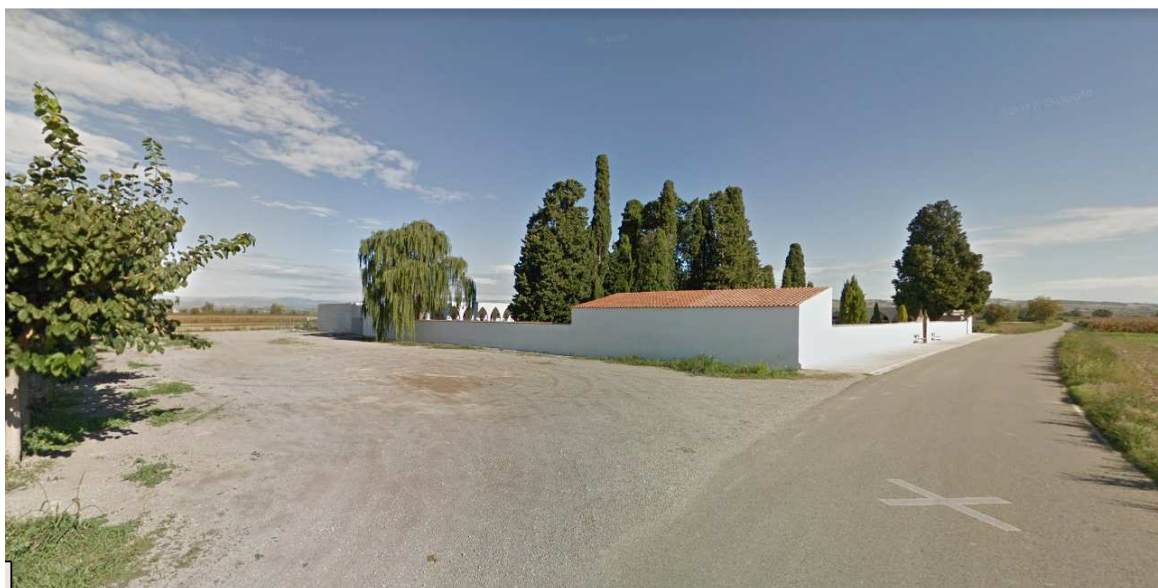
Entrada d'accés a la Planta de GNL
